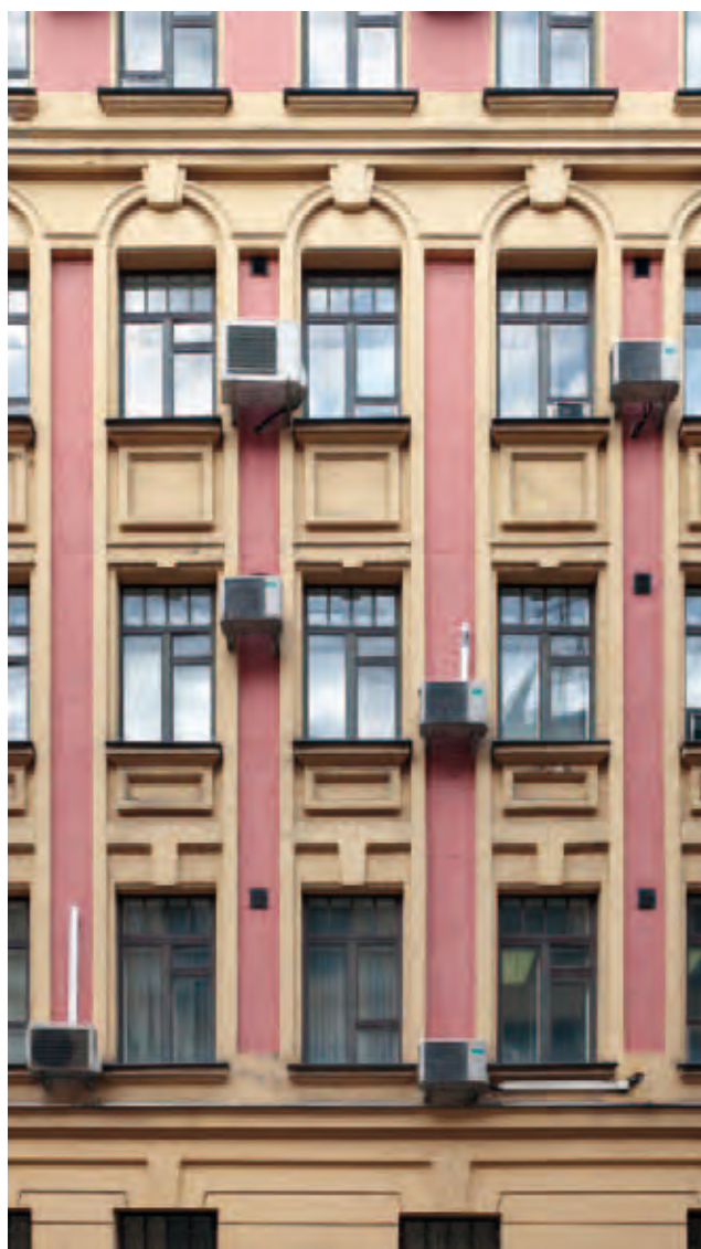
Общий вид дома А.Ф. и Н.Ф. Бочаровых с Гоголевского бульвара Фрагмент фасада дворового корпуса доходного дома
