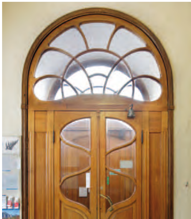
Портал входных дверей со стороны вестибюля
