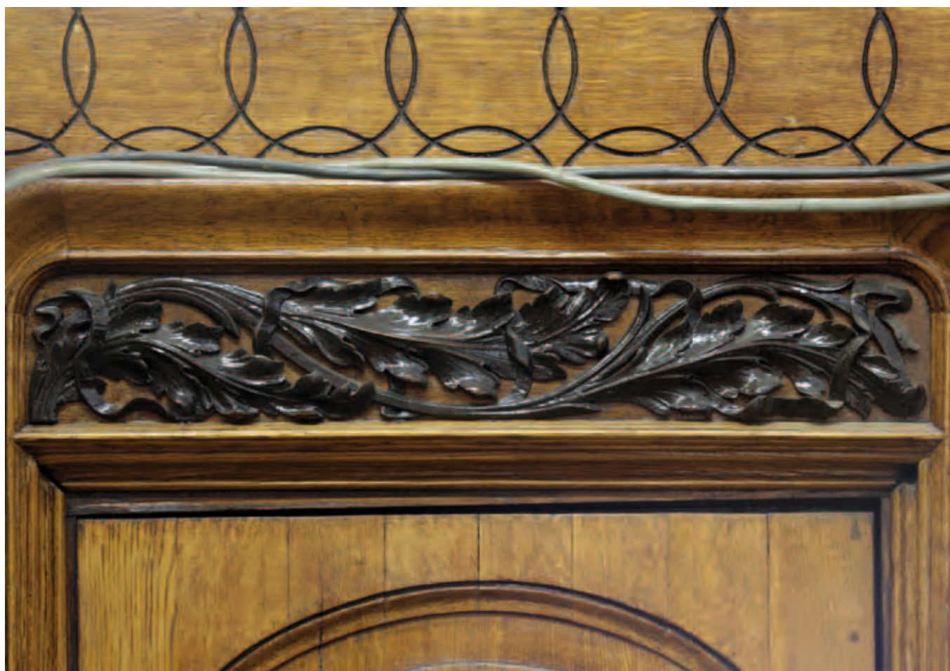
Фрагмент летнего декора башни особняка Общий вид особняка со стороны улицы Остоженка. Фотография 1910-х годов Резной декор двери в туалетную комнату
