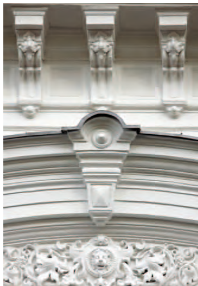
Фрагмент фасада главного усадебного дома
