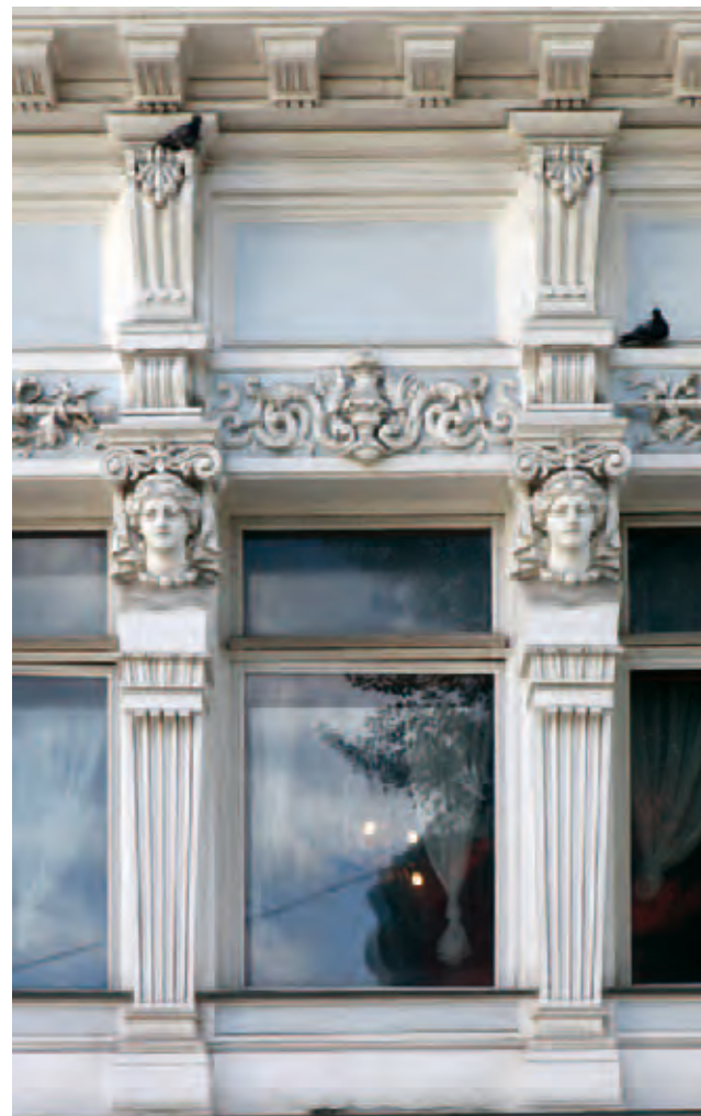
Декоративная отделка трёхчастного окна столовой на боковом фасаде особняка
