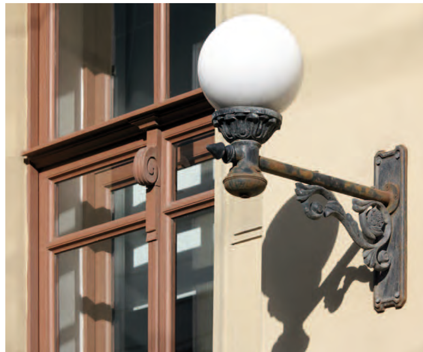
Оконная рама первого этажа
