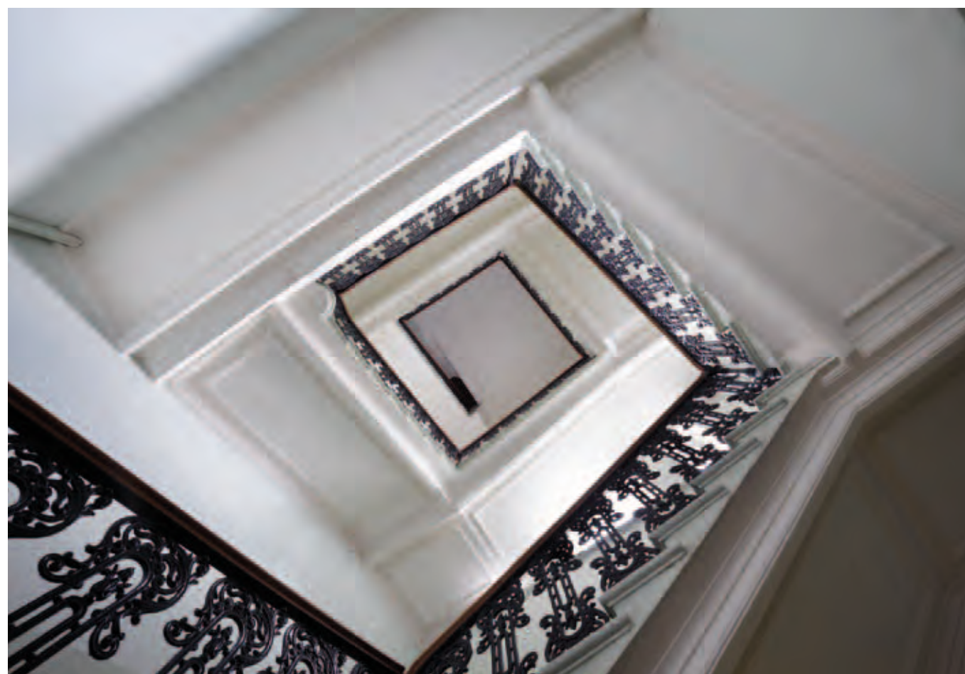
Декоративные обломы карниза вестибюля Парадная лестница главного дома
