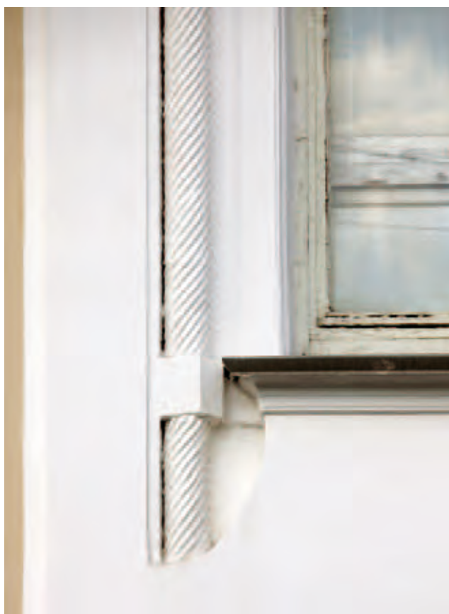
Балкон второго этажа в центре фасада Декор окна
