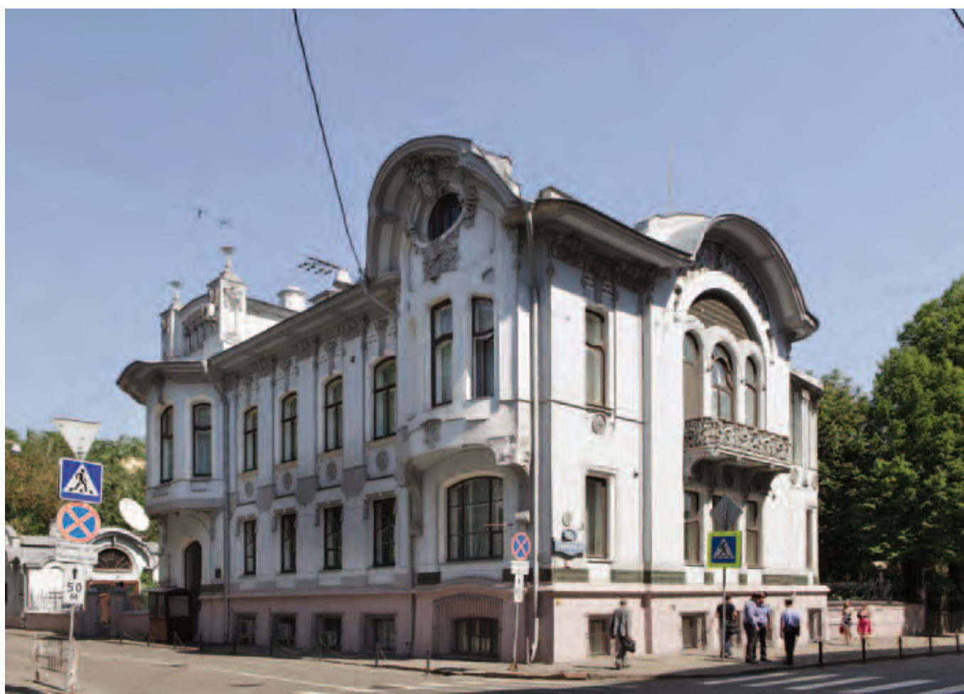
Декоративное ограждение балкона второго этажа по Поварской улице Общий вид особняка с Поварской улицы
