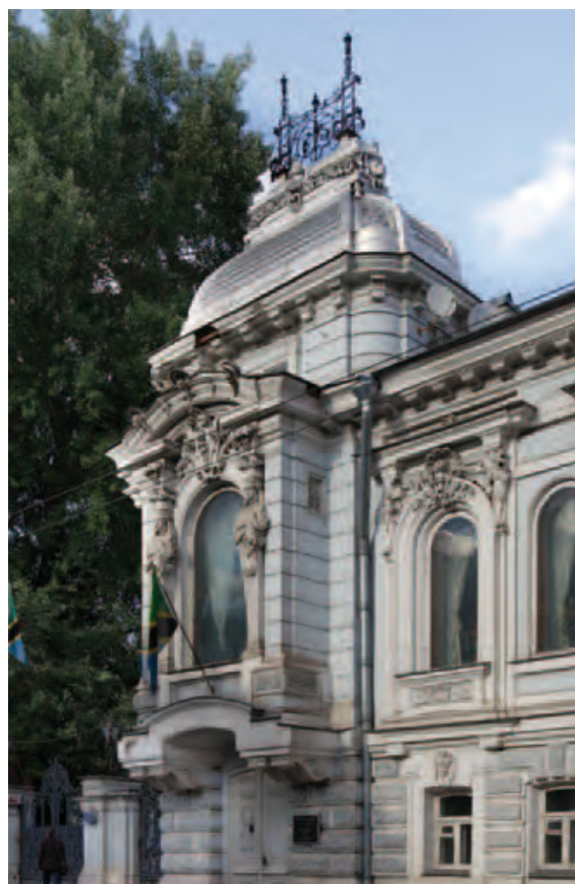
Вид пристроенной части к особняку со стороны улицы
