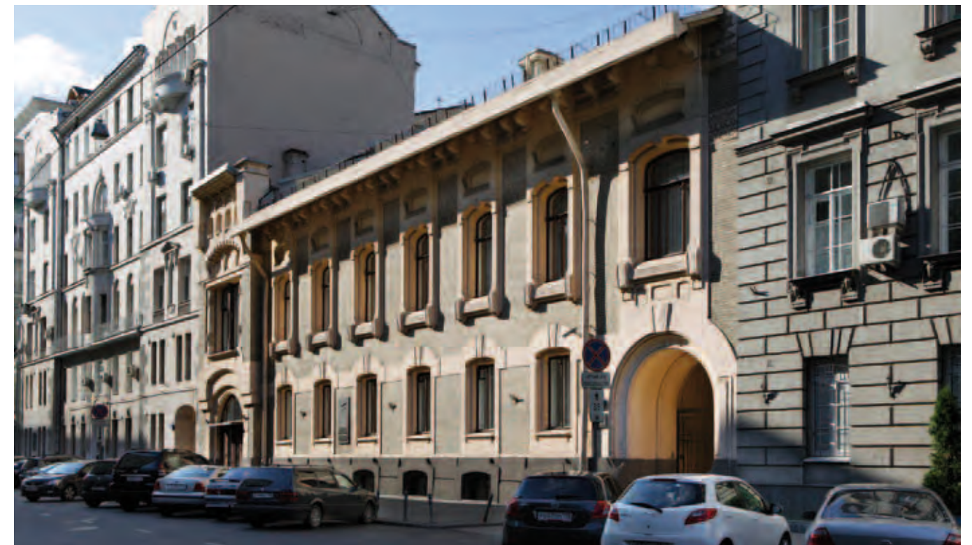
Общий вид особняка с Поварьской улицы
