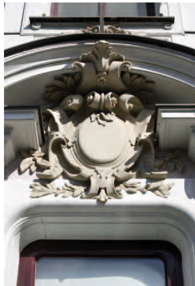
Детали лепной отделки помещений особняка Наличники окон первого этажа
