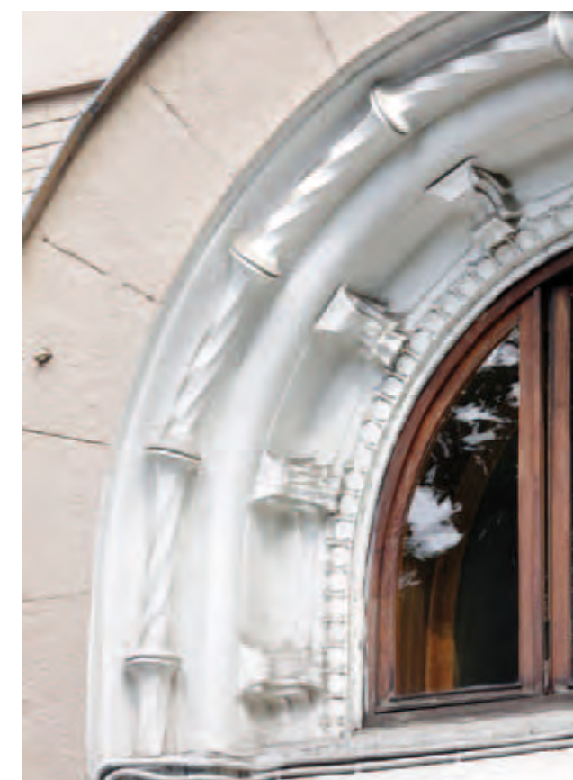
Кованый кронштейн навеса над входом в лечебницу Фрагмент лепной отделки полукруглого окна над входом в лечебницу
