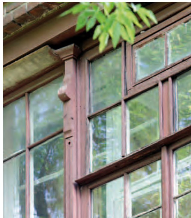
Плитка керамического напольного покрытия лестничной площадки Фигурный импост фасадного окна
