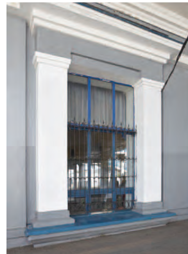
Эдикула окна на главном фасаде здания
