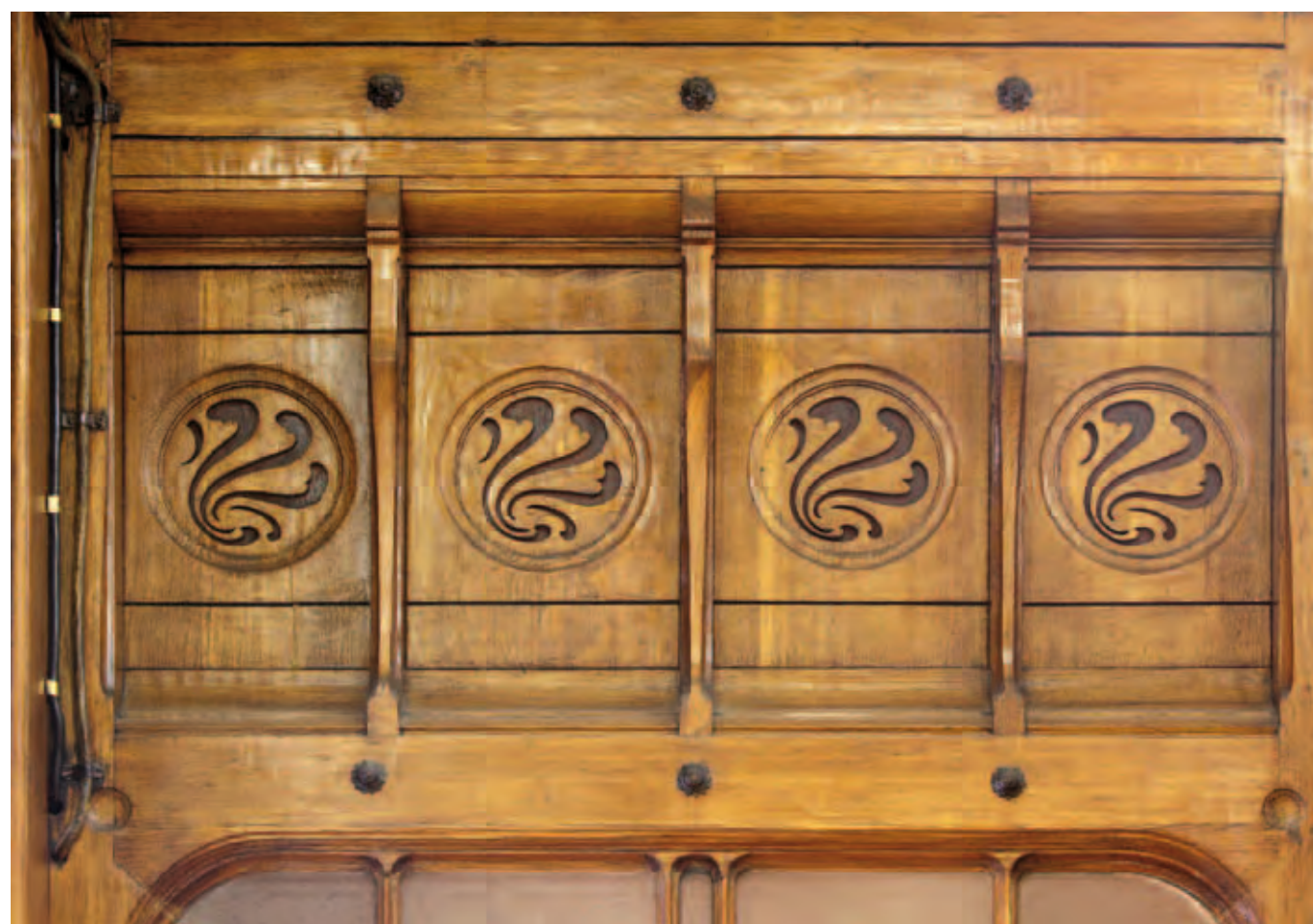
Вид ограждения парадной лестницы
