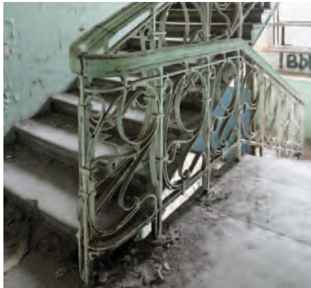
Лестничное ограждение (строение 1)
