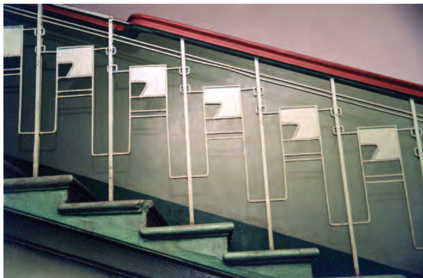
Лестничные площадки, декорированные керамической плиткой Рисунок лестничного ограждения
