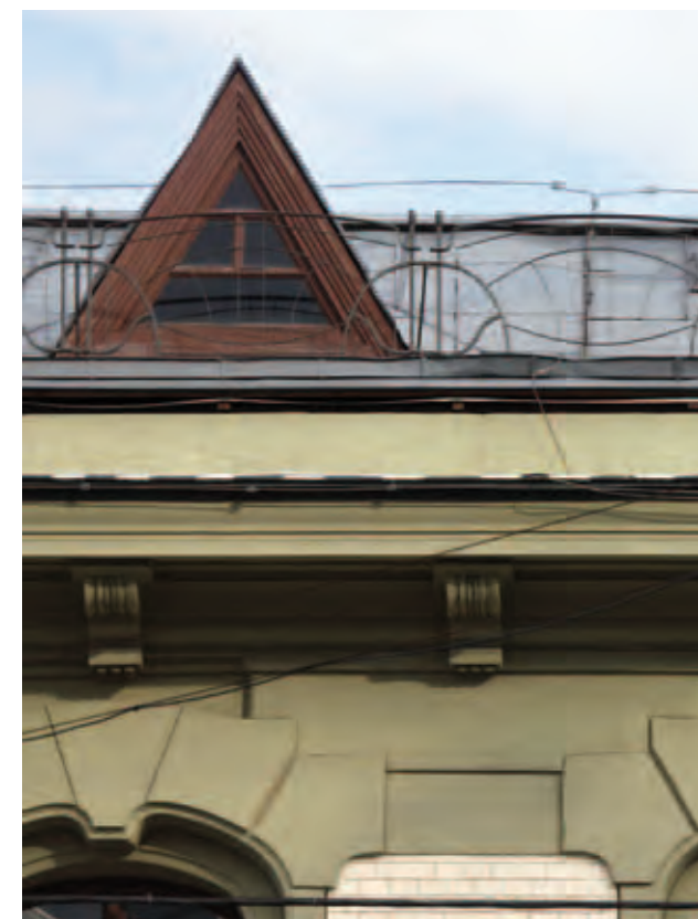
Решётка ограждения свеса кровли доходного дома Арка дома. Вид со двора Общий вид доходного дома А.И. Кекушевой
