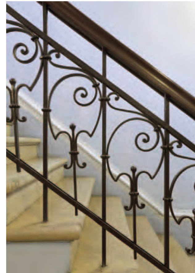
Фрагмент кованого лестничного ограждения
