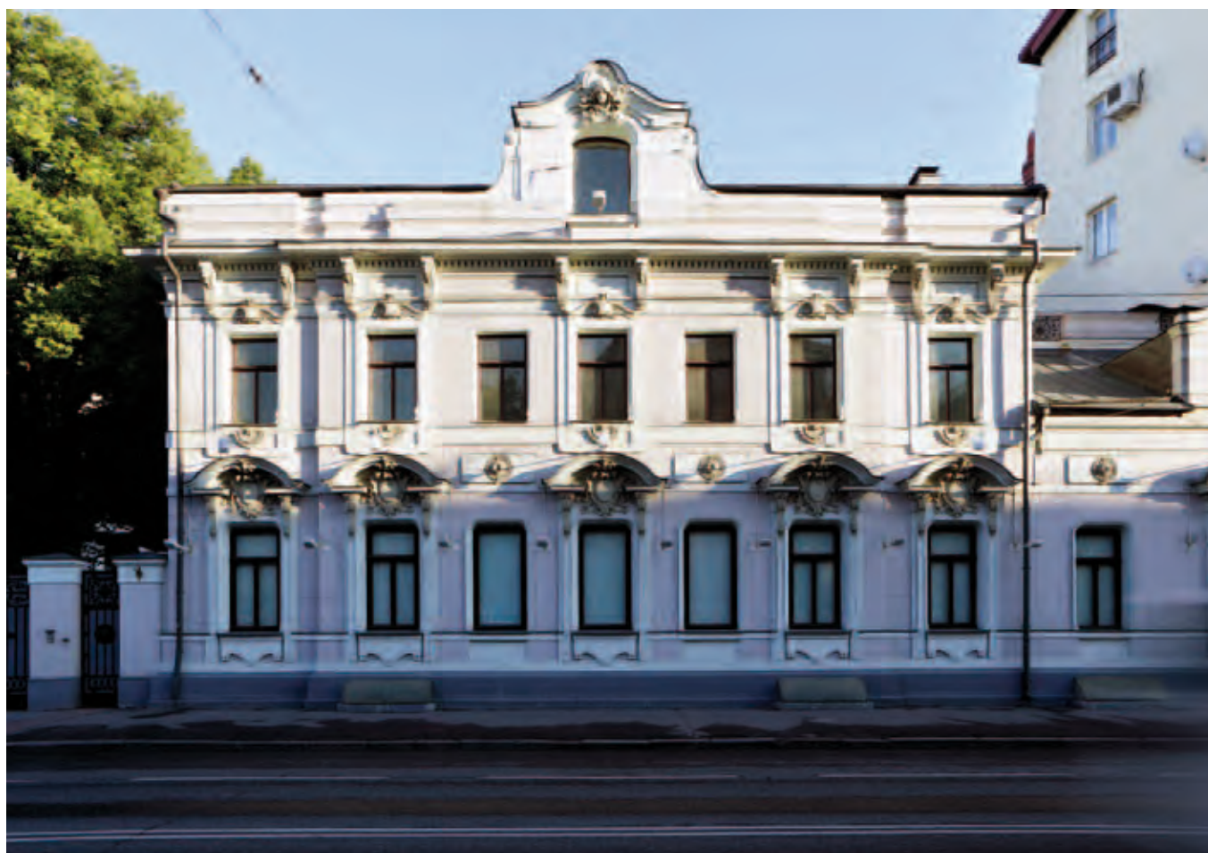
Своды Монье в полуподвале особняка Общий вид особняка с улицы Остоженка
