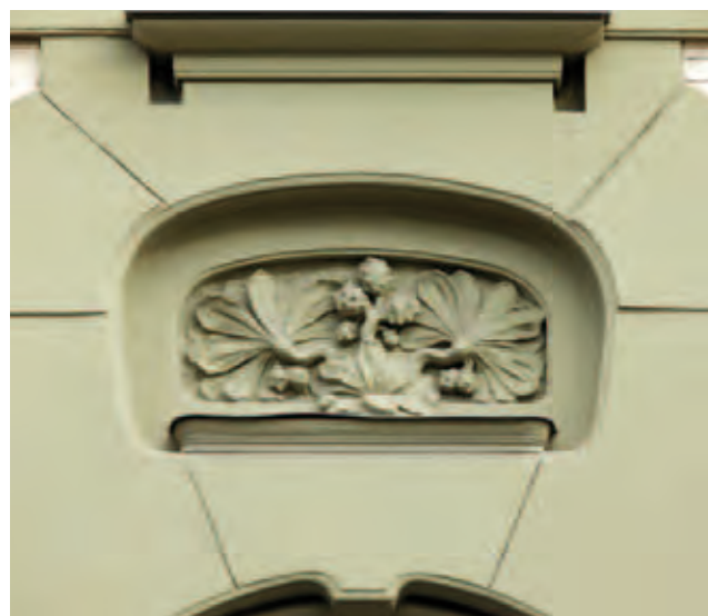
Лепной декор над окном бокового ризалита Фрагмент фасада с лепным декором Лепнина над окном второго этажа
