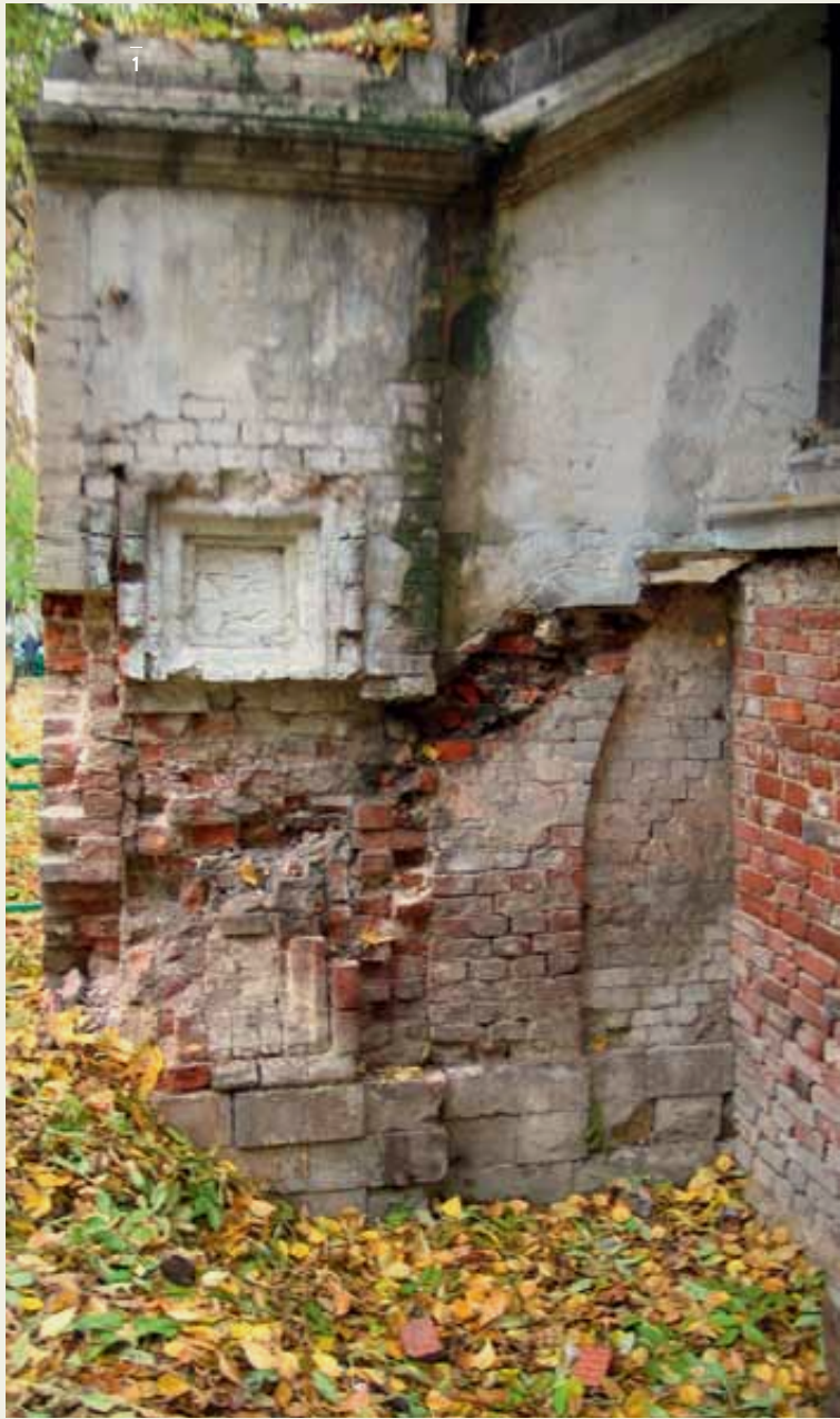
1 Фасад дома причта до реставрации 2-3 Фрагменты интерьеров до реставрации 4 Дом причта после реставрации. Современный вид
