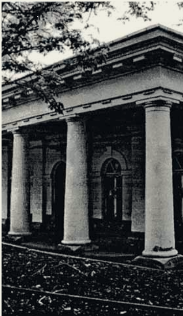
1–2 Фрагменты фасада гауптвахты Хамовнических казарм до реставрации
