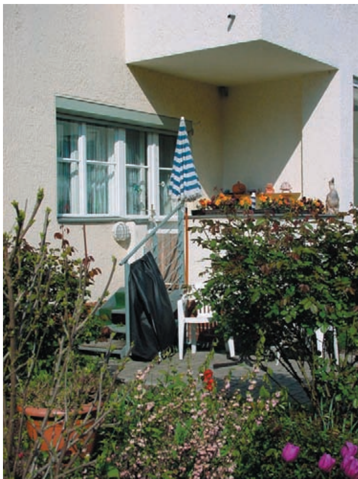
Новый доступ к балкону
