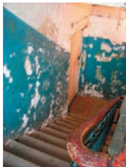
Treppenhaus im Wohngebäude des Flugzeugwerkes. Typischer Zustand
