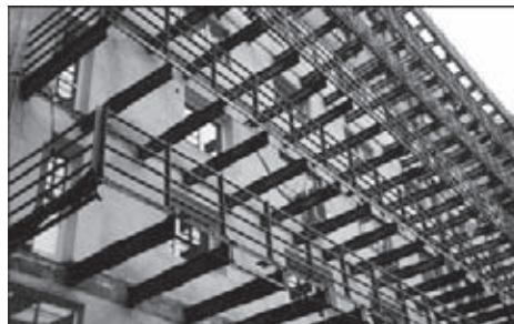
Дом-коммуна, 1929 год, арх. И.С. Николаев. Фрагмент фасада. Орджоникидзе ул, д. 8/9
