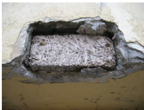
Фибролитовая теплоизоляция дома Наркомфина в Москве
