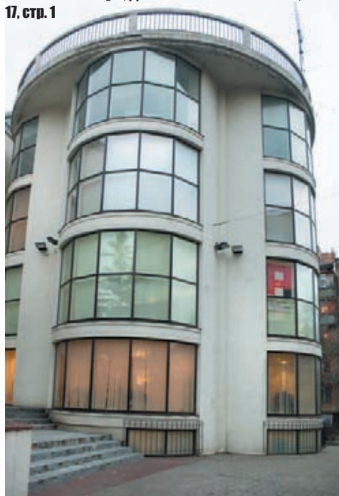
Klubhaus der Fabrik „Burewestnik“, 1927—29, Architekt K.S. Melnikow. 3. Rybinskaja-Straße 17, Bau 1
