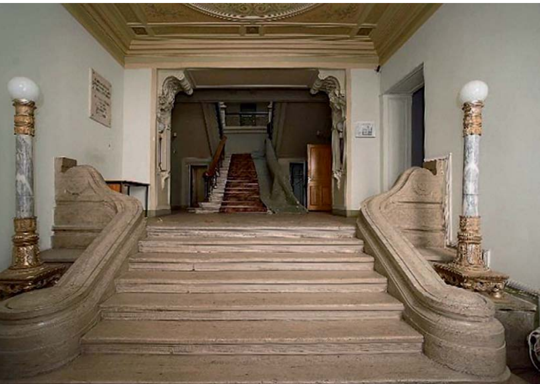
Вестибюль и лестница первого этажа до и после реставрации
