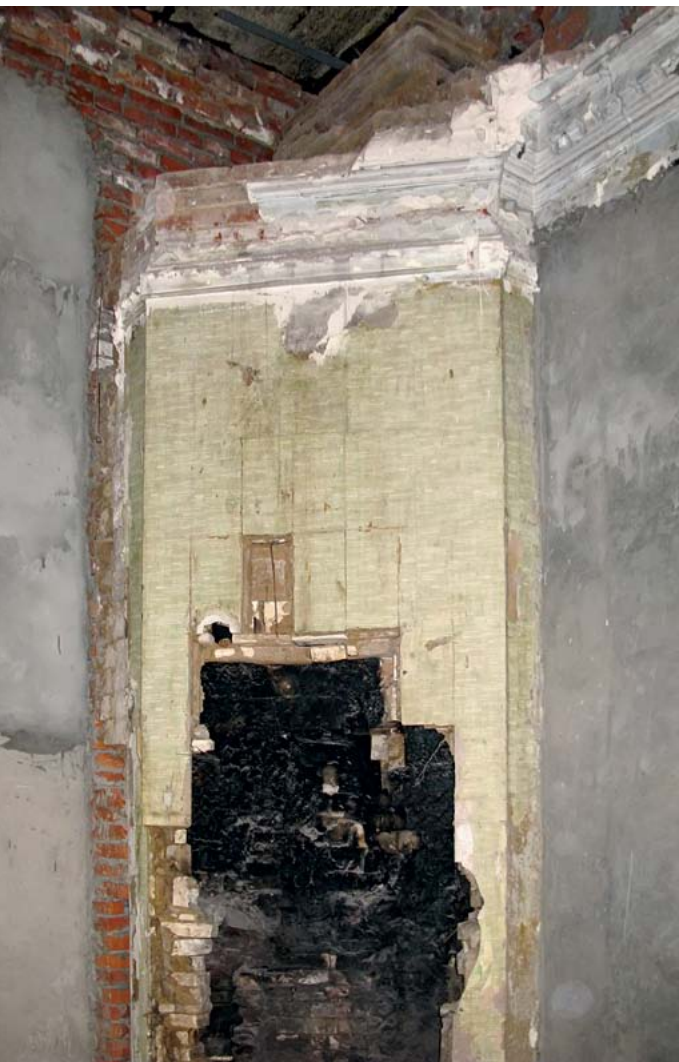
Историческая печь второй половины XVIII в. в помещении второго этажа до и после реставрации
