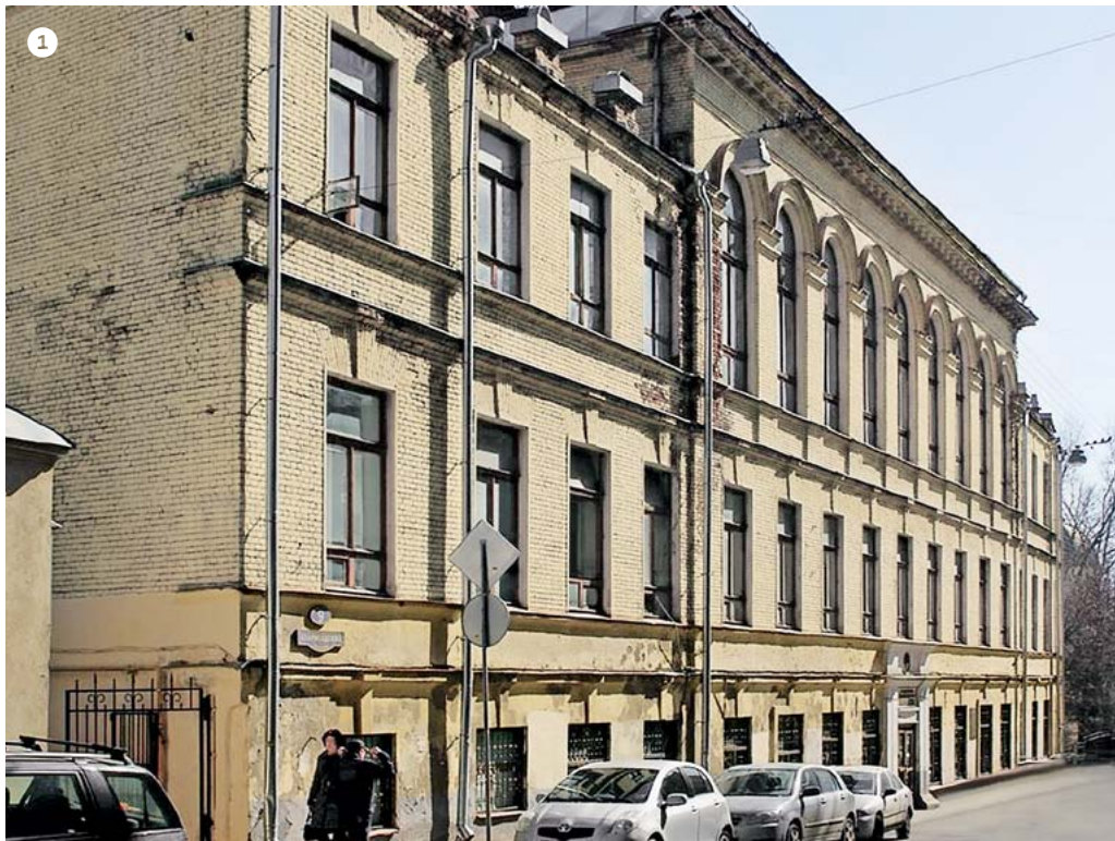
1 Главный фасад до и после реставрации 2 Портал главного входа до и после реставрации
