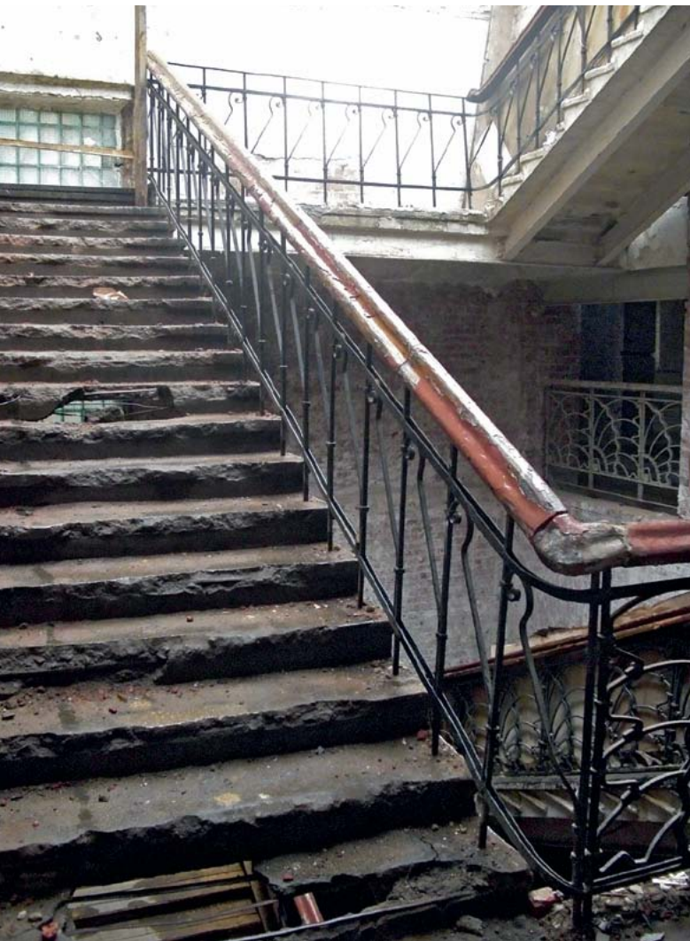
Лестница в процессе и после реставрации
