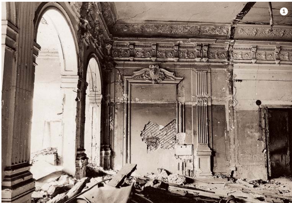
1 Пиллястровый зал до реставрации, 1993 г. 2 Пиллястровый зал после реставрации 3 Элемент декора после реставрации
