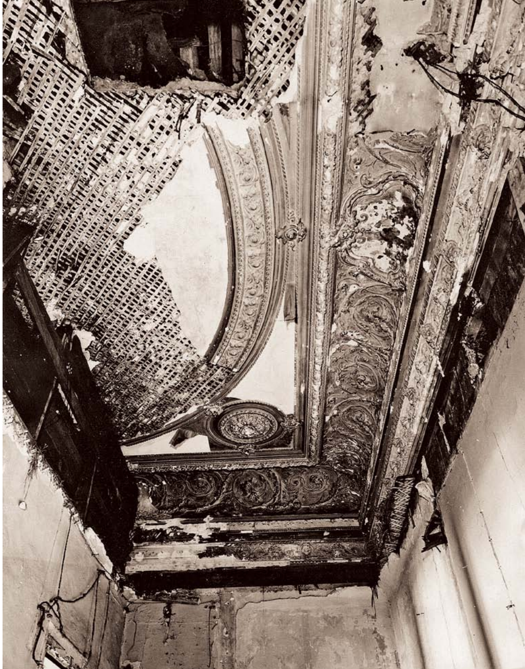
Фрагмент плафона Белой гостиной до и после реставрации
