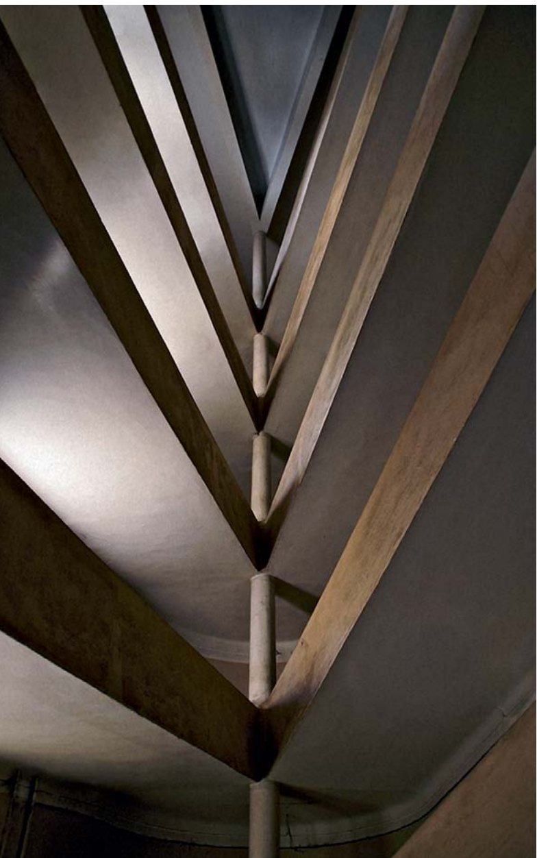
Пандус санитарного корпуса до и после реставрации
