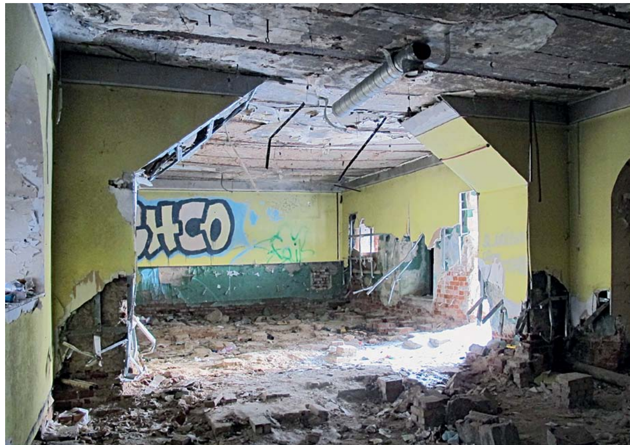
Состояние одного из помещений до начала реставрационных работ
