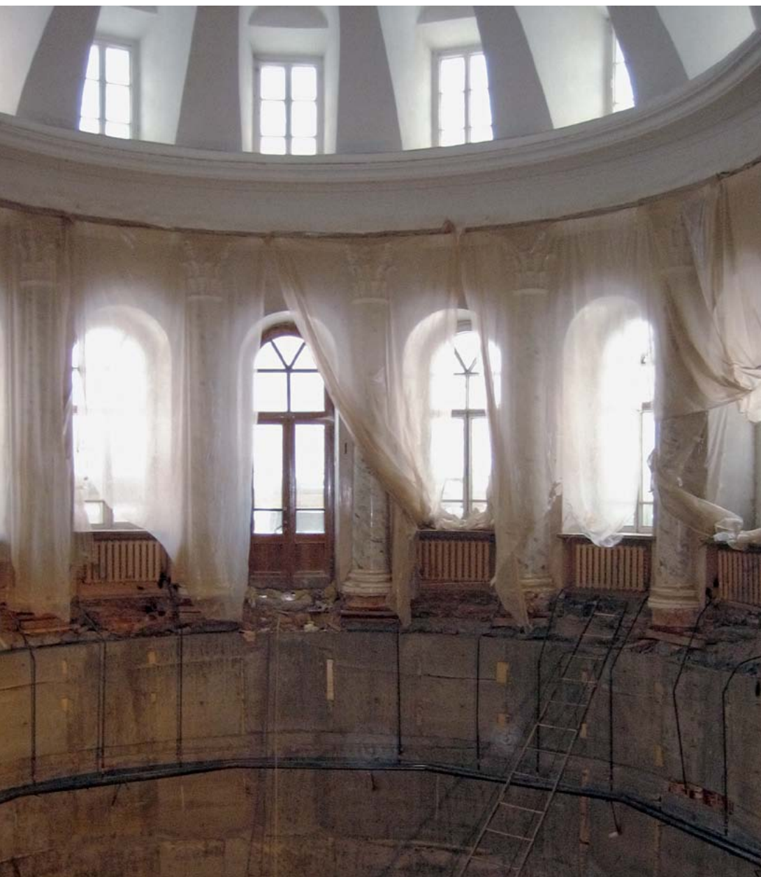
Овальный зал до и после реставрации
