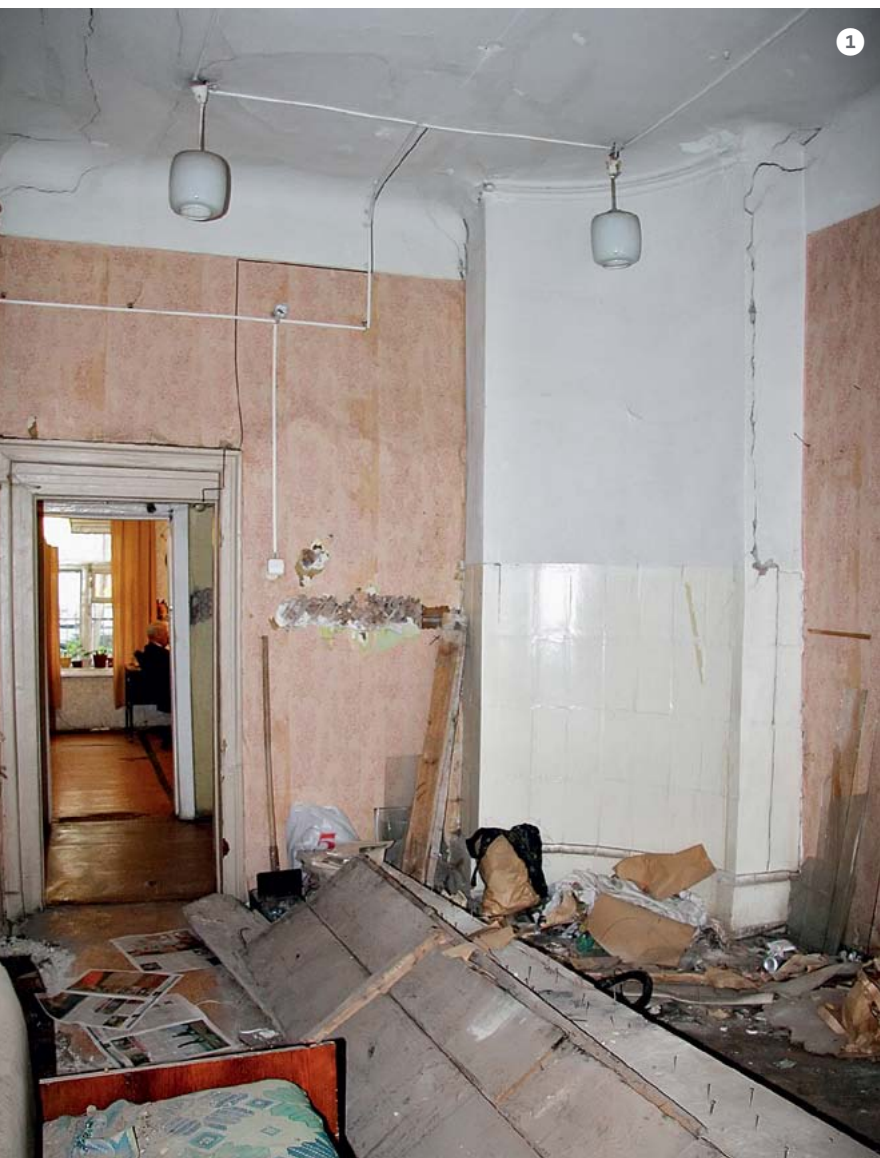
❶ Остатки угловой печи в зале анфилады первого этажа до реставрации
