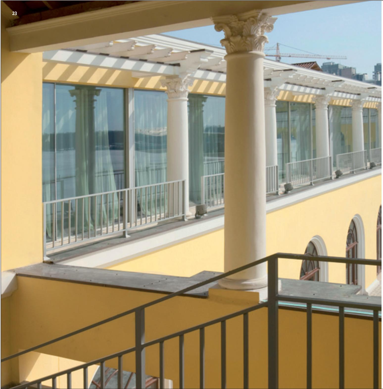
В ходе ремонтно-восстановительных работ по трибунам стадиона были отреставрированы железобетонные конструкции, обновлён штукатурный слой и профилированные тяги, металлические ограждения, лестницы. Была воссоздана одна из двух декоративных фигур завершения пилонов — «Парусник».
