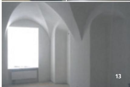
Окна второго этажа немного уменьшены по высоте в нижней части по уровню хорошо сохранившейся ниши во второй северной оси. Растёсы под новую столJARку прослеживаются в кладке стены. В третьем этаже в двух крайних осях с севера и юга восстановлены глухие квадратные ниши.
