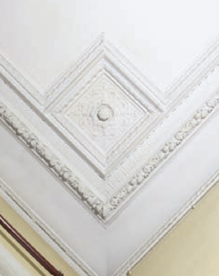
Лепной декор одного из помещений доходного дома
