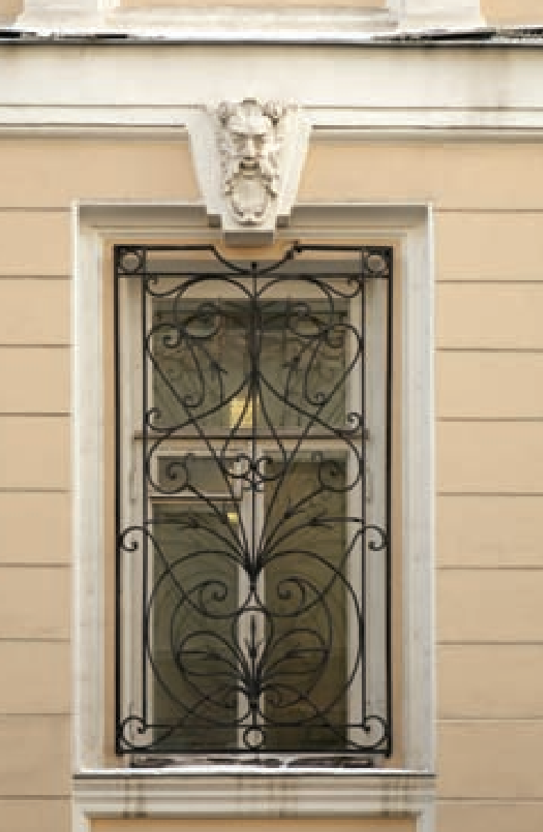
Фрагмент главного фасада усадьбы с лепным декором
