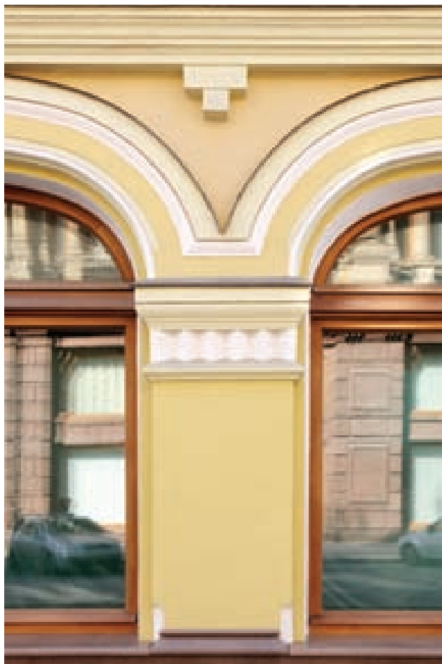
Фрагмент фасада первого этажа
