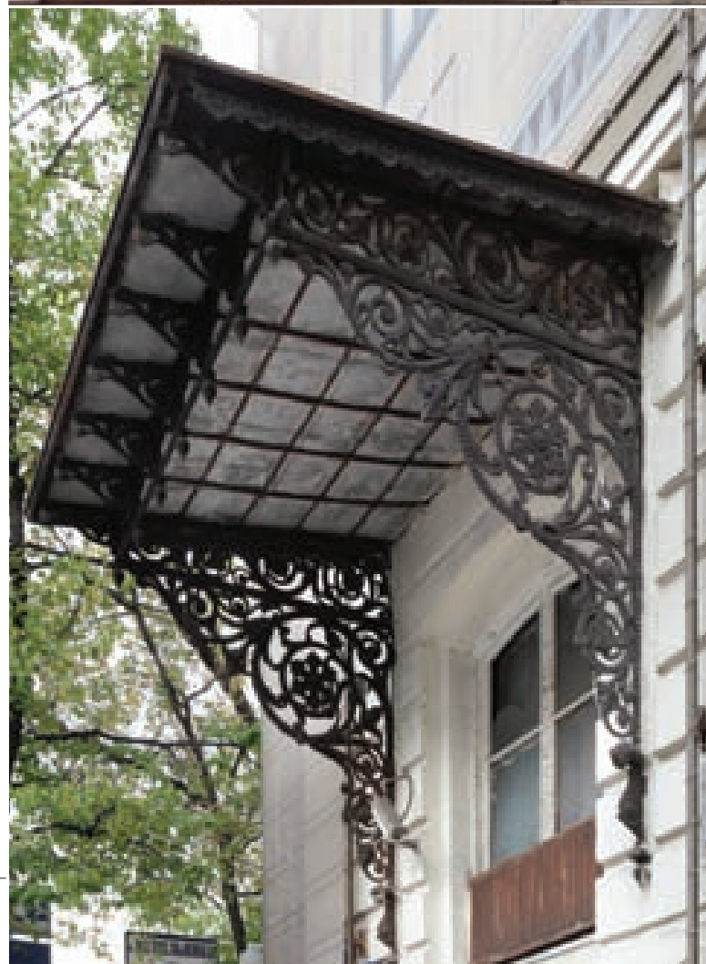
Металлический козырёк над входом главного фасада учебного корпуса
