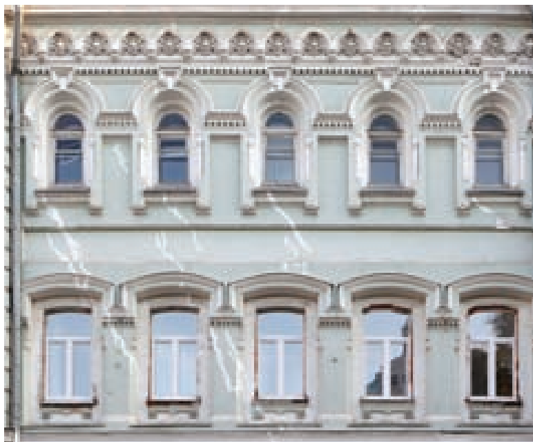
Окна с арочным завершением боковой части уличного фасада
