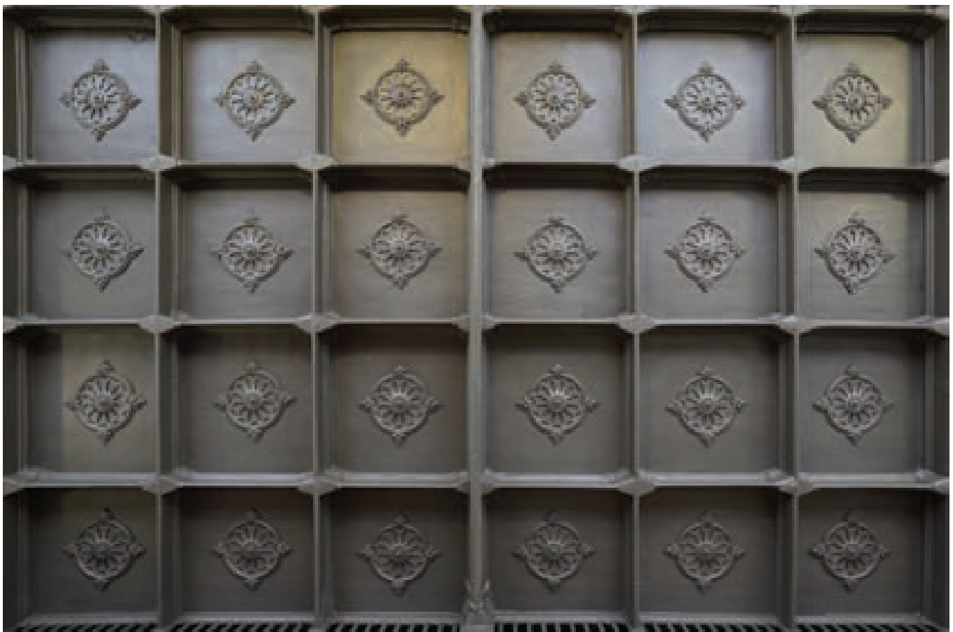
Фрагмент балконных перекрытий
