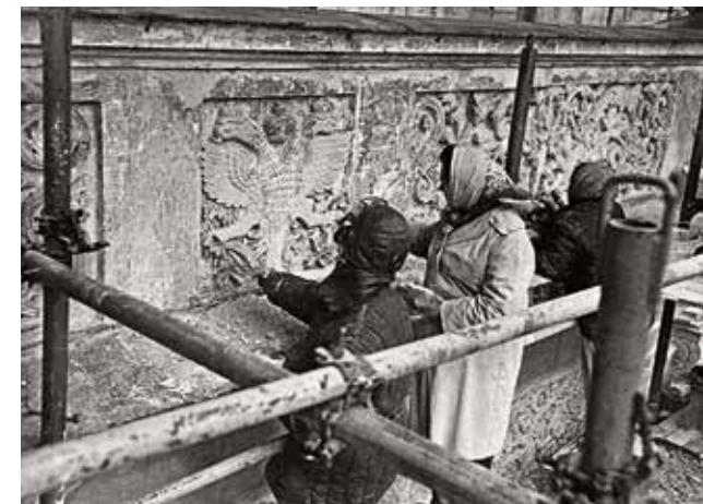
Работы реставраторов на парапете теремов. Указания архитектора И. П. Рубен Фото, 1960-е Архив д. н. Кульчинского
