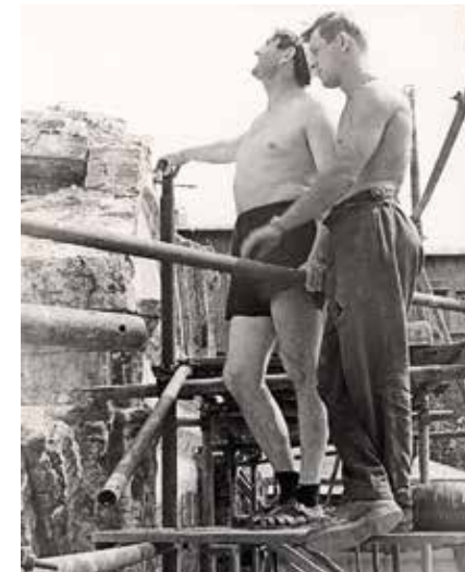
Д. Н. Кульчинский (слева) на объекте реставрации Фото, 1960-е АРХИВ Д. Н. КУЛЬЧИНСКОГО
