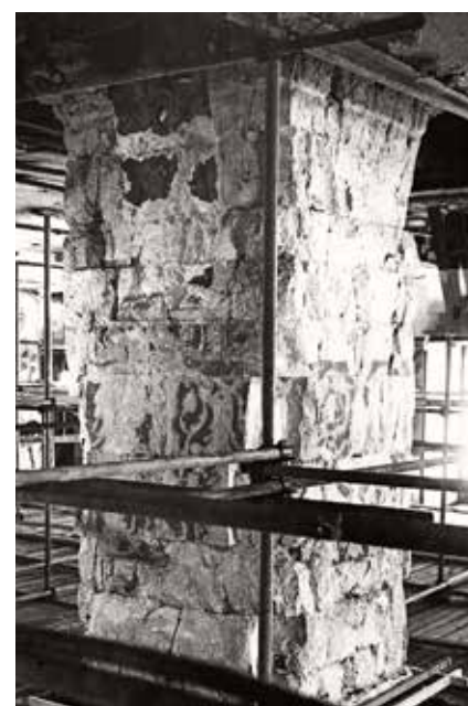
Столб Грановитой палаты, раскрытый в процессе реставрационных работ Фото, 1968 АРХИВ Д. Н. КУЛЬЧИНСКОГО
