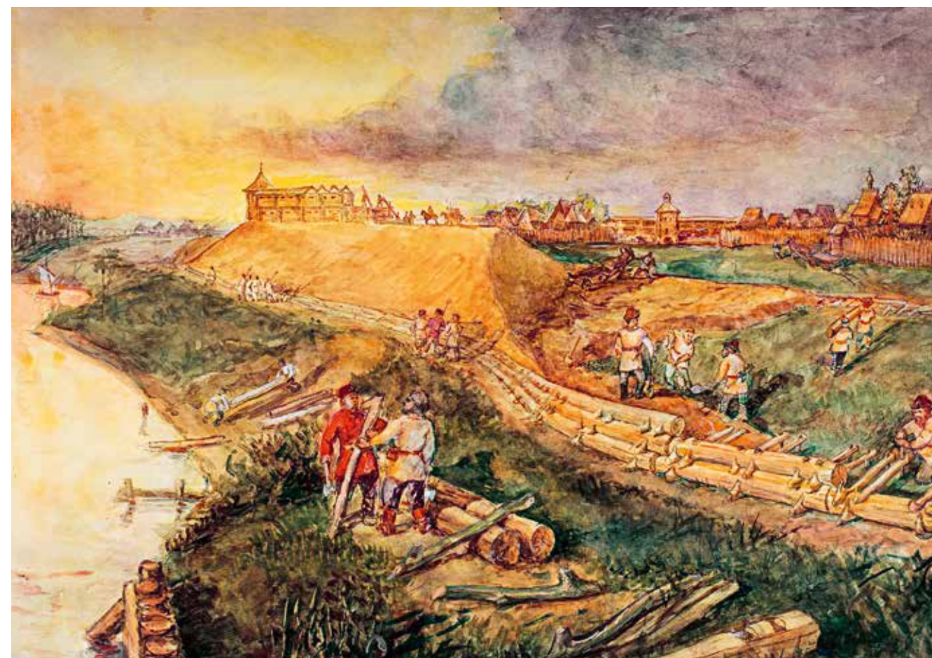
< Д. Н. Кульчинский Деревянная балка в стене Кремля, реконструкция Рисунок, 1956 архив д. н. кульчинского
