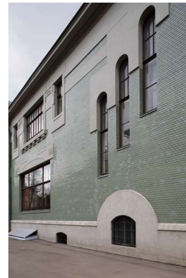
Фрагмент правого бокового фасада особняка А.И. Держинской
