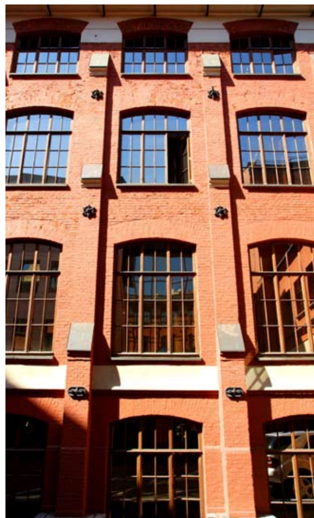
Фрагмент правого дворового фасада здания скоропечатни «Левенсон А.А.»
