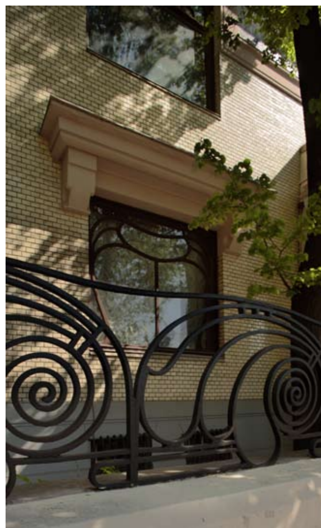
Фрагменты фасада особняка и решётки ограды
