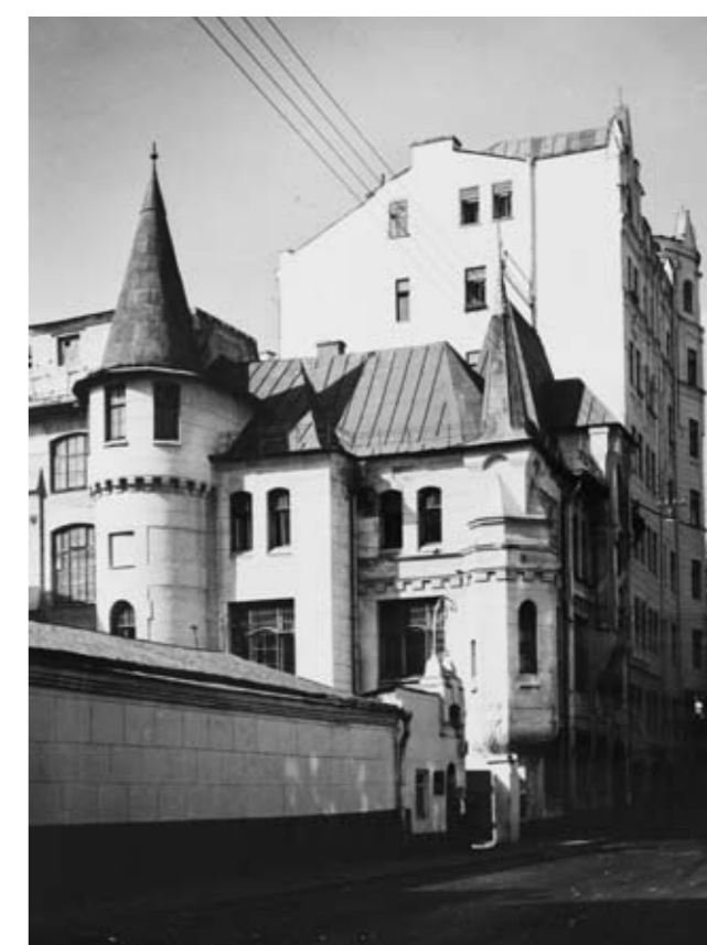
Боковой фасад здания скоропечатни «Левенсон А.А.». Вид с угла. Архивное фото начала XX в.
