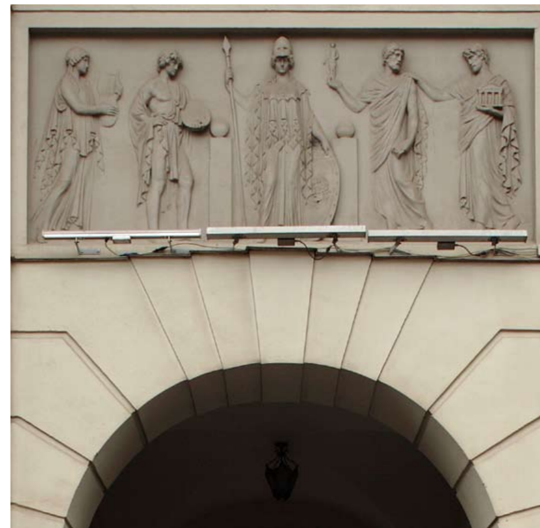
Рельеф над въездной аркой особняка Ф.О. Шехтеля
