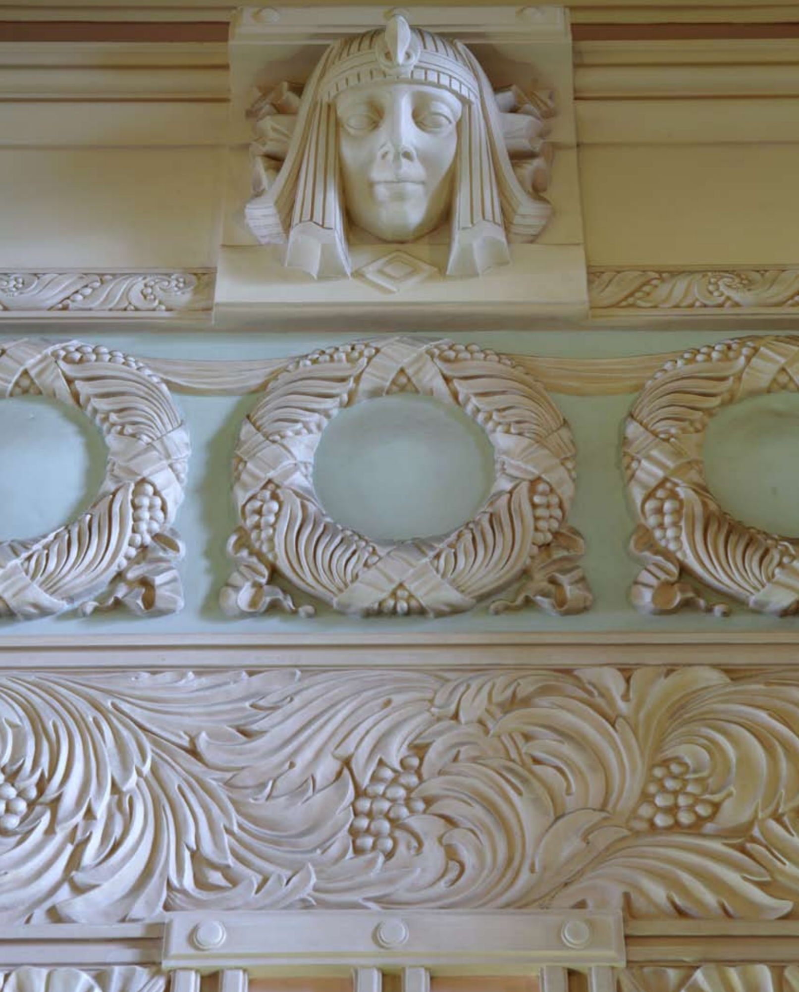
Фрагмент фриза входного вестибюля доходного дома А.И. Шамшина
